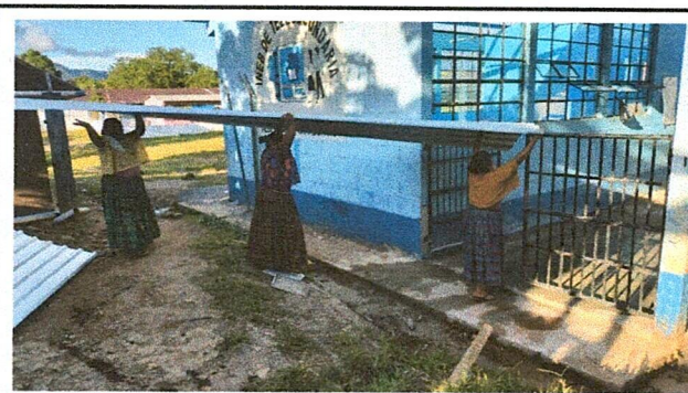
Foto 4: Este material será para la sustitución del techo del Edificio Público.
