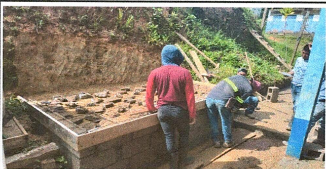
Foto 3: Es cuando estaban trabajando la base de los dos tinacos.
