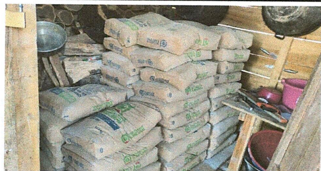
Foto1: Este material será para la reparacion de la losa del Edificio Público
